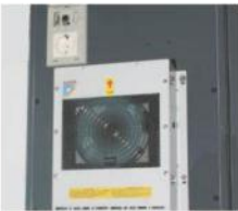
Intercambiador de calor · Transmisión de calor eficiente integrada desde el armario de distribución.
