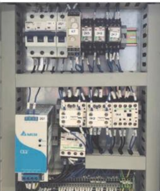
Caja eléctrica · Fuente de alimentación de 24 V. · Todos los contactores y relés SIEMENS o Schneider .
